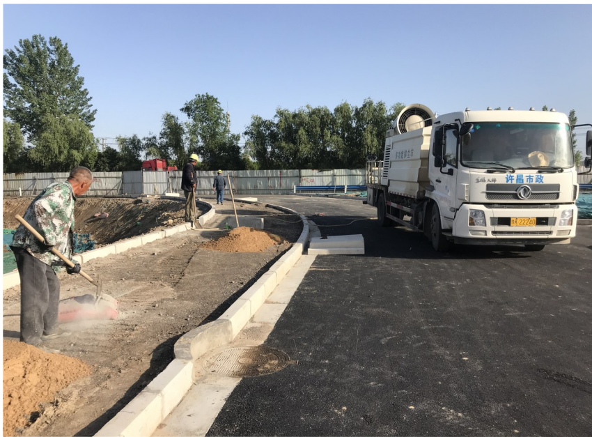
正在打通的滨河路万通大道至永昌大道路段进行收尾工作。
