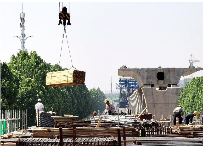
葛天大道站施工现场 记者 吕正子 摄
