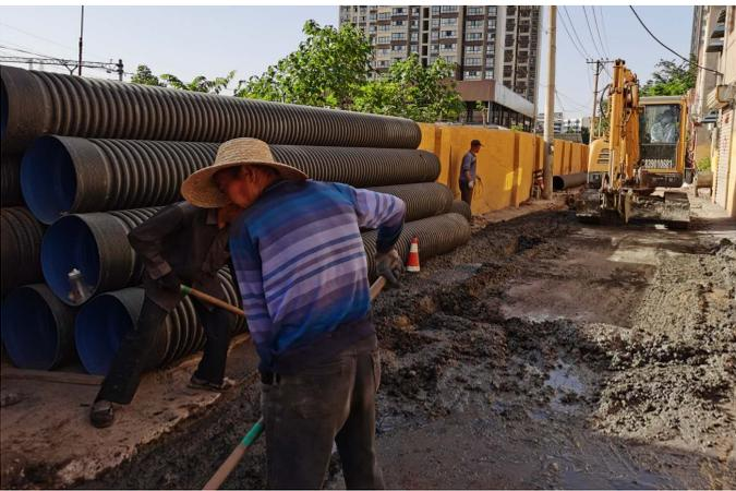
工人在冯庄巷对管道沟槽进行回填。
