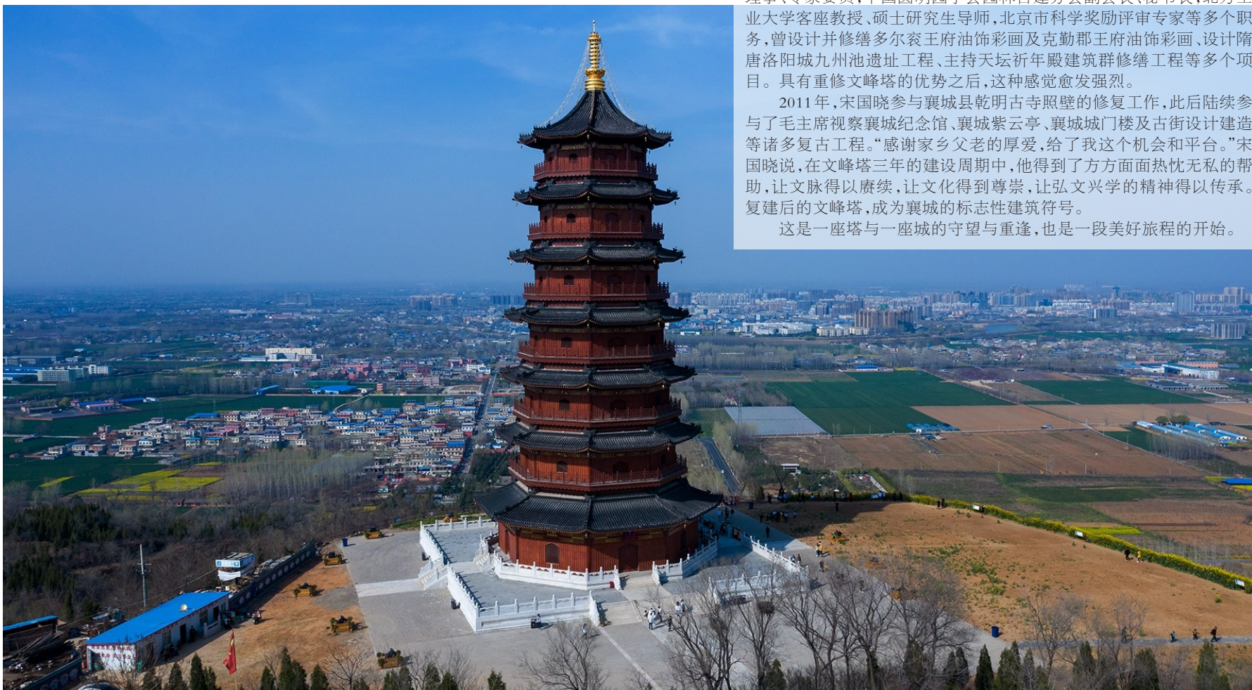
位于首山之上的文峰塔，为外十三层、内七层楼阁式建筑，平面呈正八边形，塔高66米。张全喜 摄
