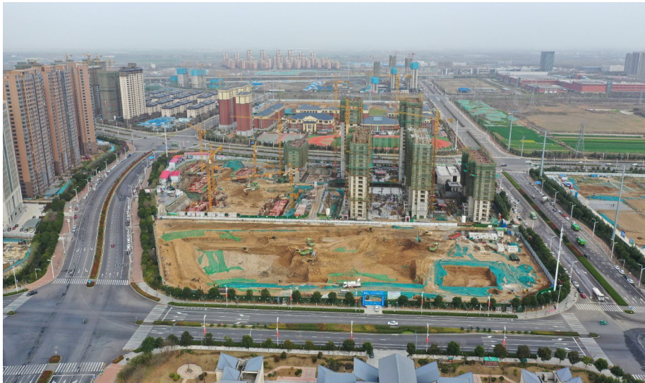
正在建设的对德合作重点项目德仕堡生活广场 记者 牛书培 摄
