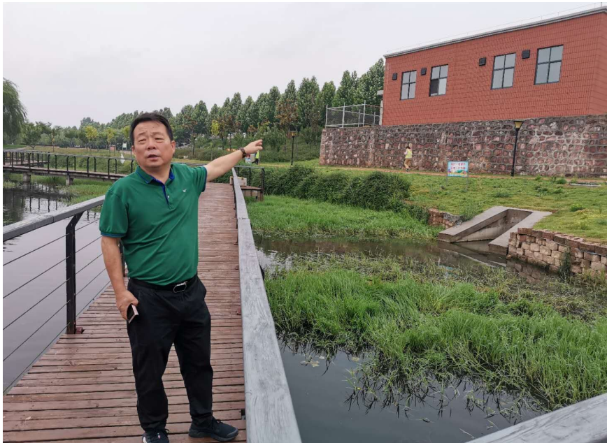
魏都区水利局供排水中心主任任道远介绍雨水泵站的情况。
