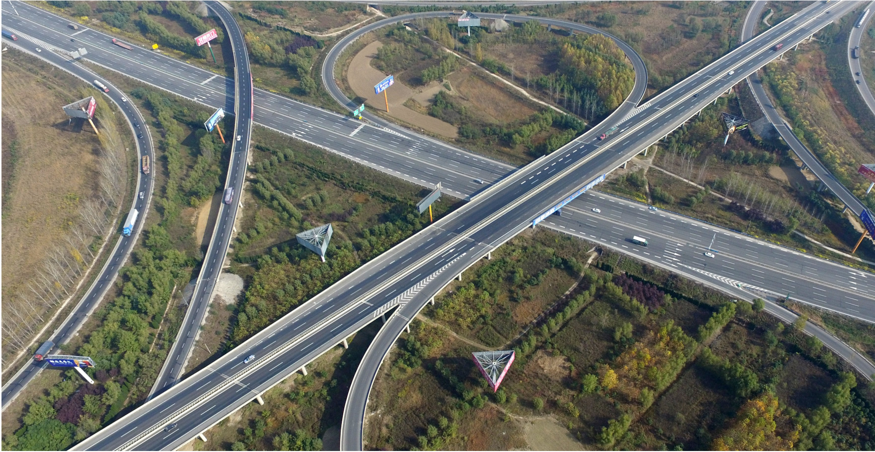
许昌境内京港澳高速公路与永登高速公路交会处的互通立交网 记者 牛书培 摄
