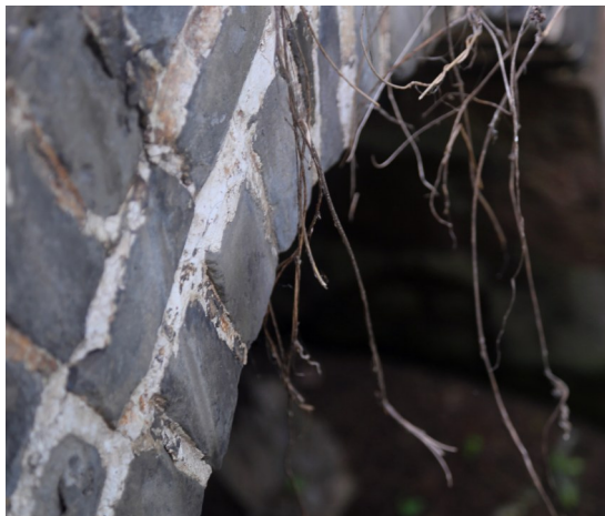
灵井寨东寨门前的寨河桥
