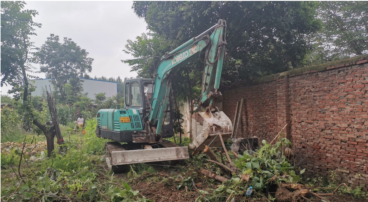
清除菜园现场 实习生 马卓 摄
