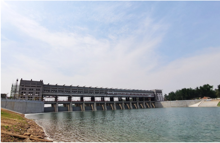
大陈闸基本竣工,已开始蓄水。 记者 张辉 摄
