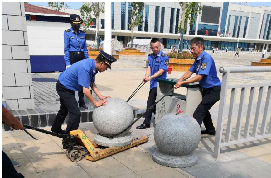
城管队员正在安置石墩。 记者 张铮 摄
