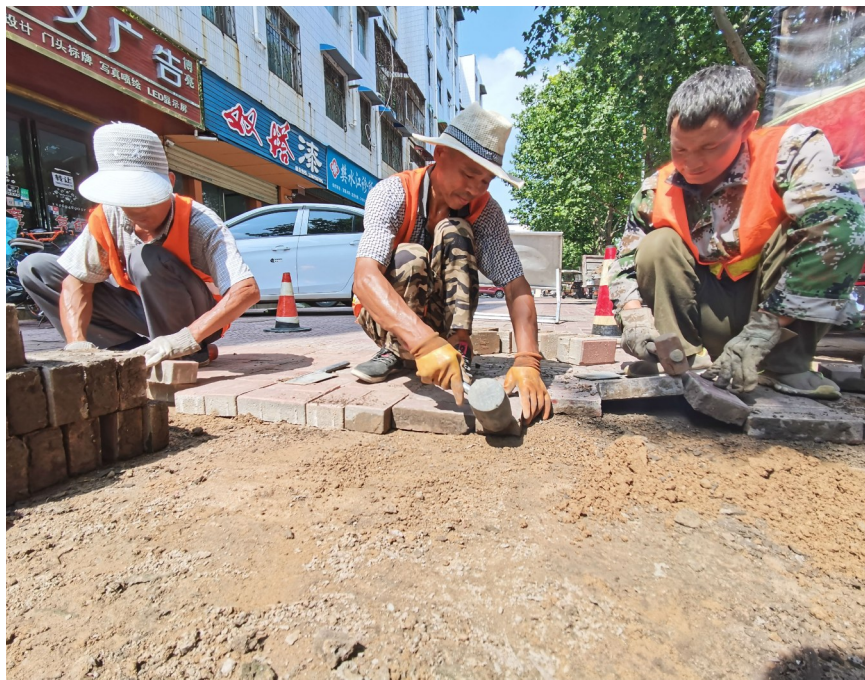
8月17日，市政工人在市区八一路与劳动路交叉口以西更换步砖。
