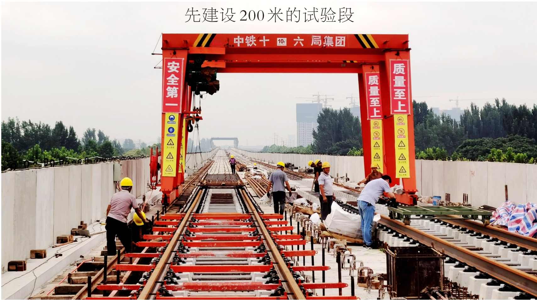
郑许市域铁路许昌段试验段铺轨施工现场 记者 吕正子 摄
