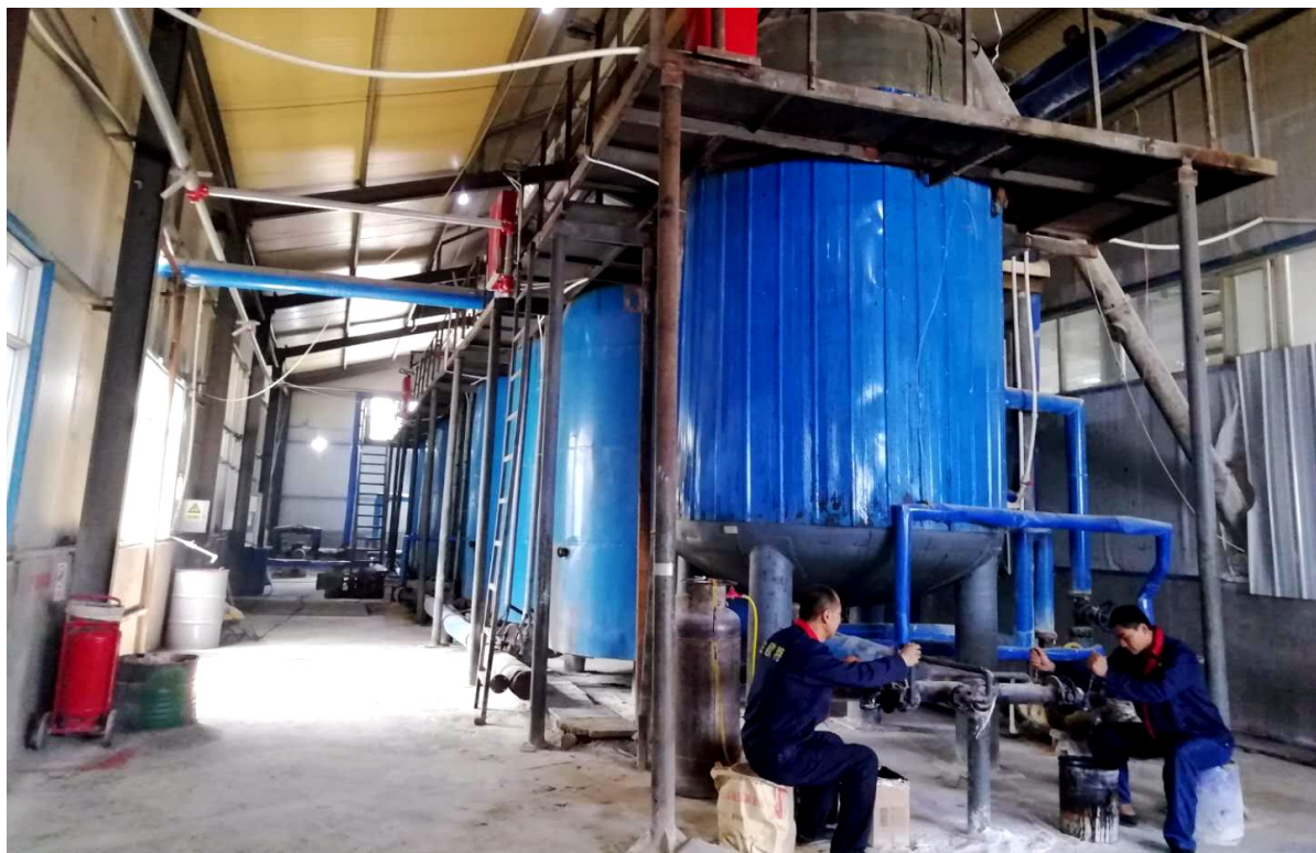
河南金欧特实业集团股份有限公司的橡胶沥青生产车间
