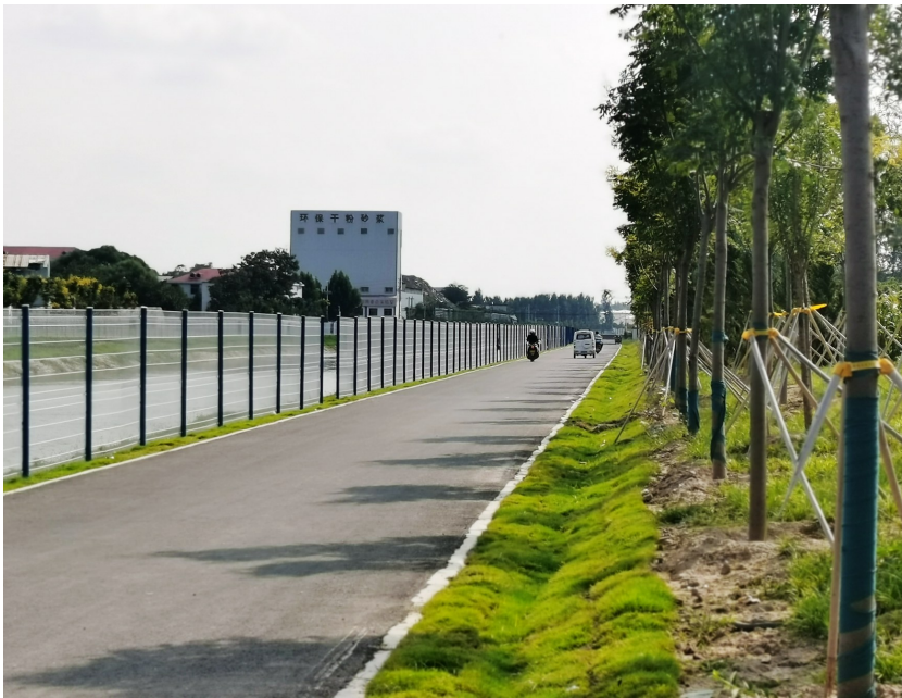
颍汝干渠魏都区段已经完工的堤顶道路
