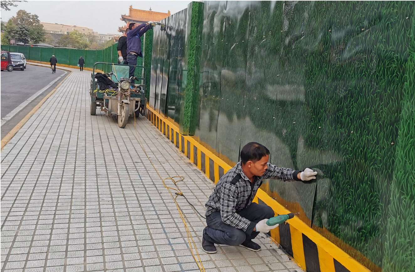
施工人员在春秋广场北半侧设置围挡。
