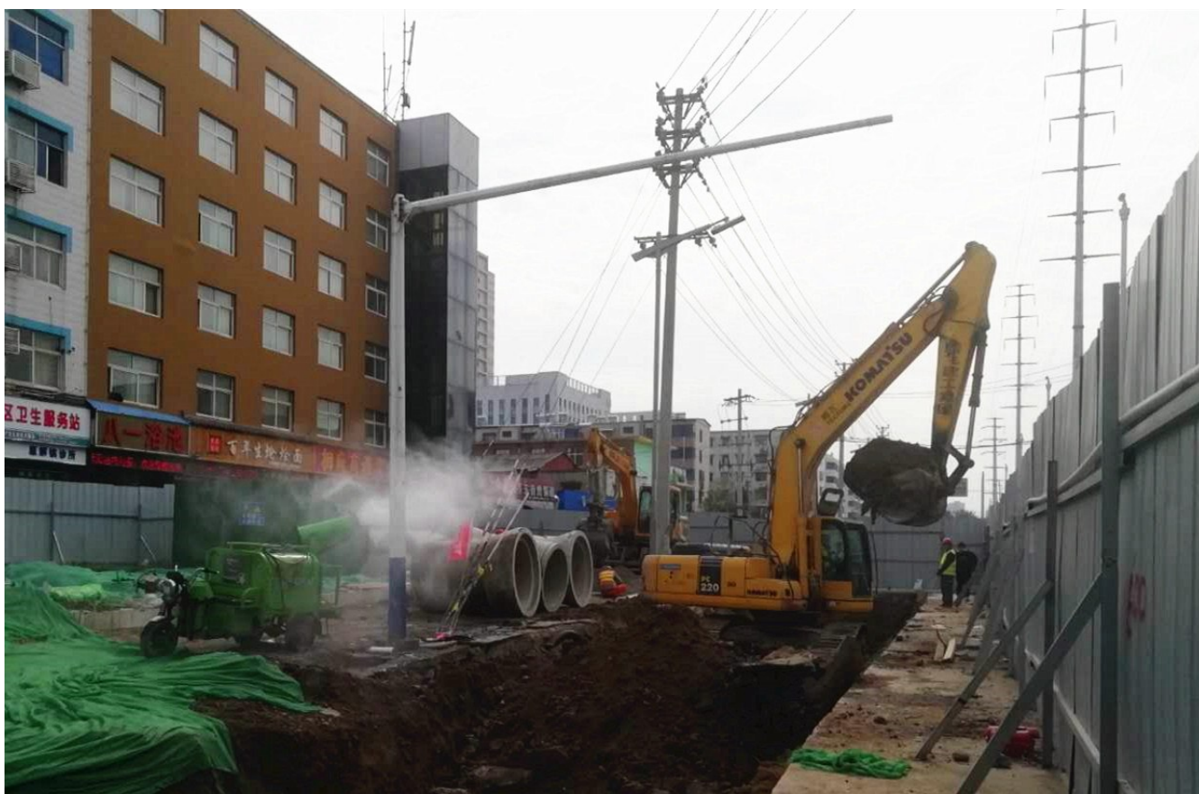
劳动路(建安大道—天宝路)施工现场
