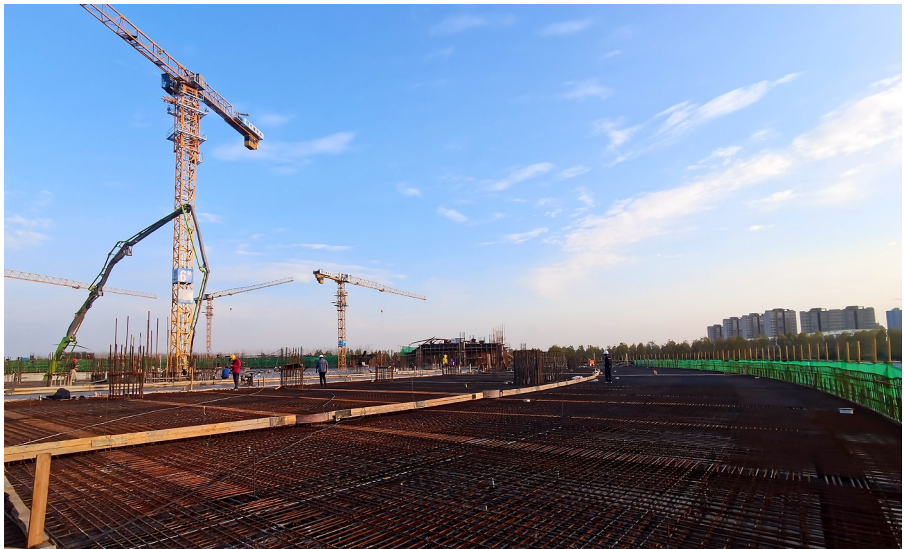
11月19日下午，还未浇筑混凝土的看台顶层。 记者 吕正子 摄
