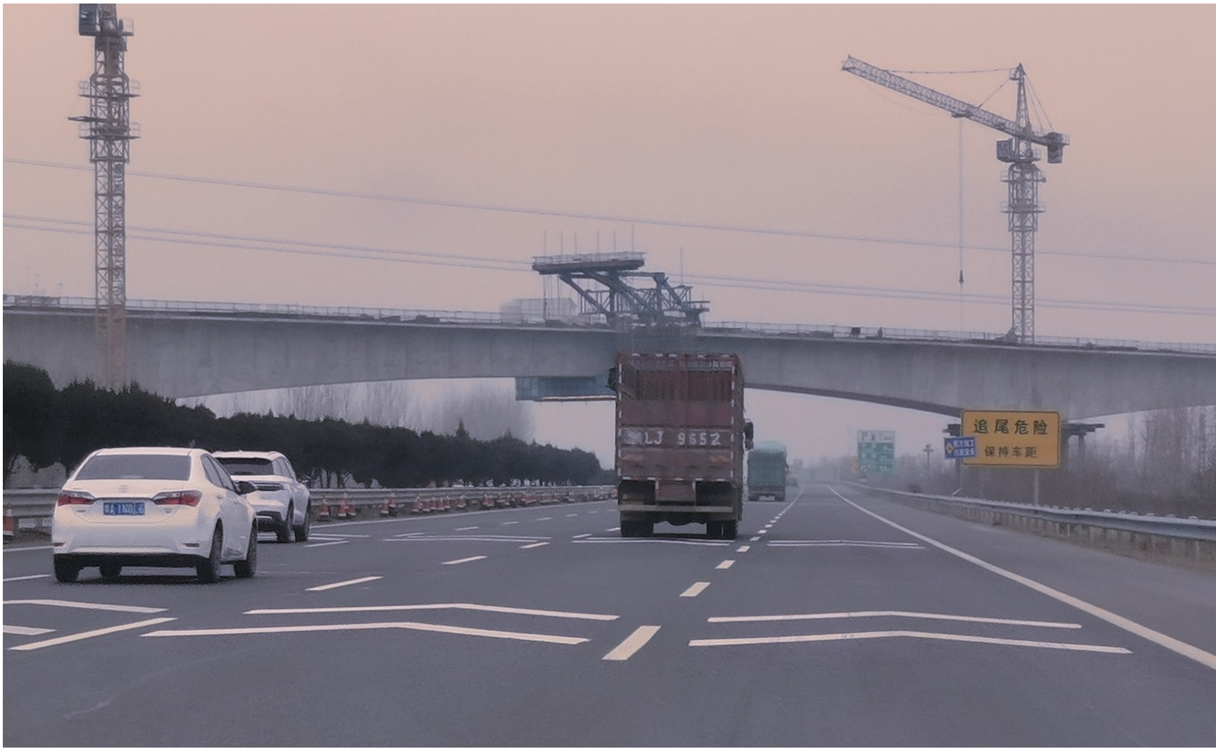
郑许市域铁路许昌段再传捷报,跨京港澳高速公路连续梁12月25日合龙。记者 吕正子 摄
