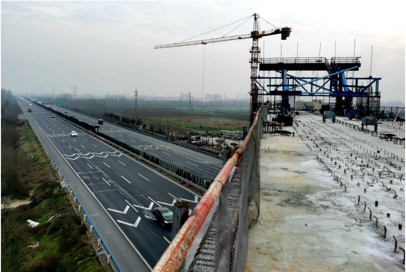
郑许市域铁路跨京港澳高速公路连续梁
