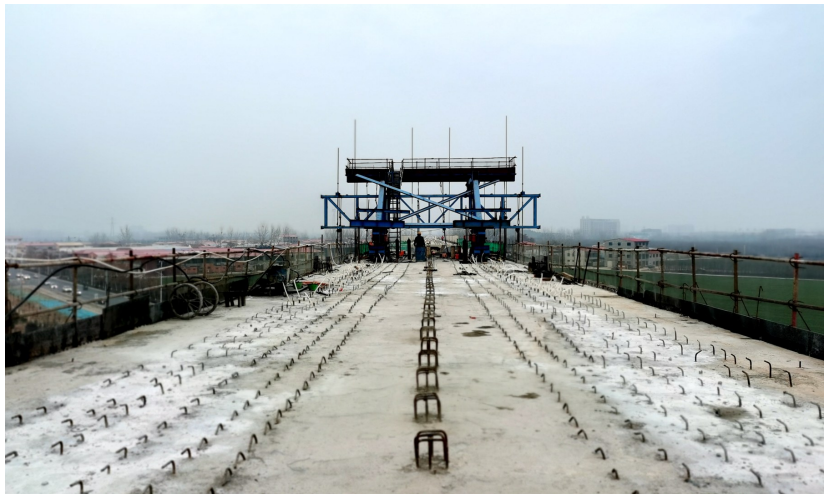
跨京港澳高速公路连续梁桥面 本文配图均由记者吕正子摄
