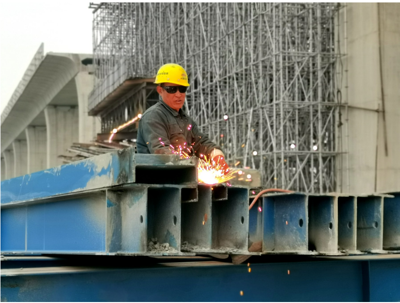
工人在拆解施工用的钢挂吊篮。
