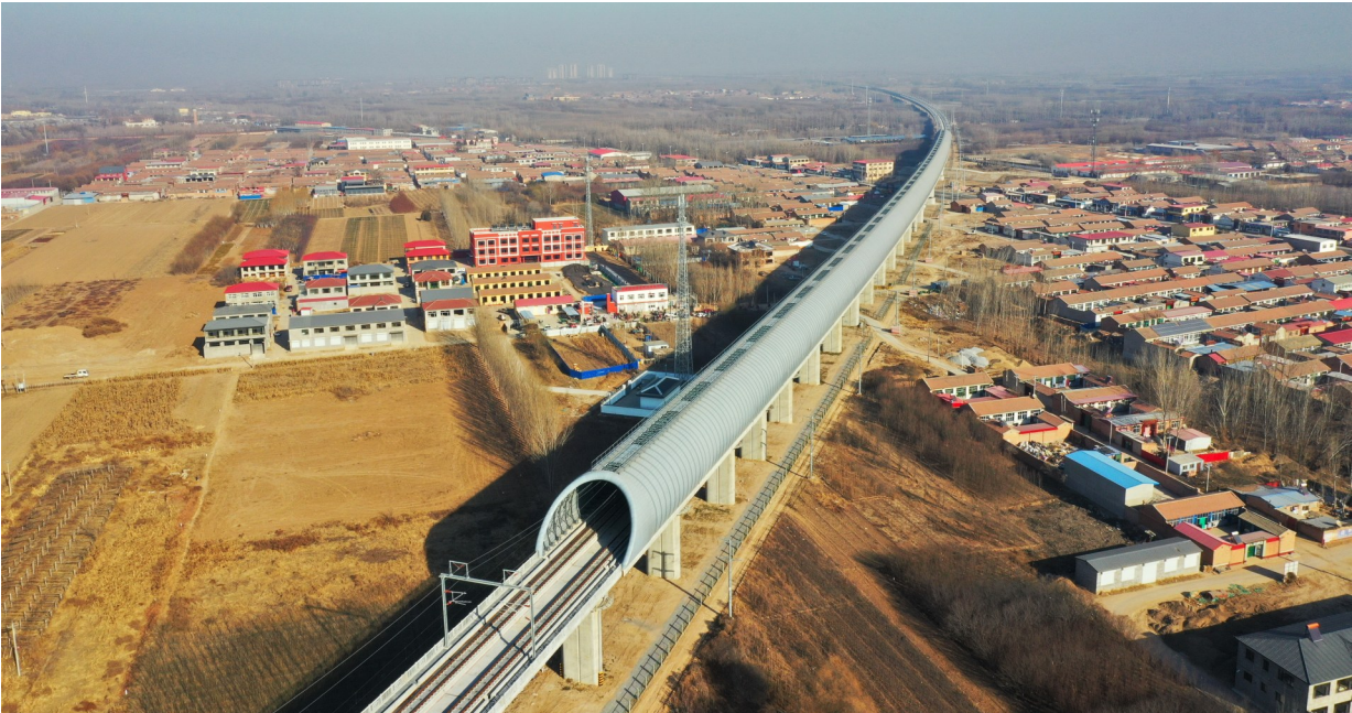
京雄城际铁路河北霸州段的全封闭声屏障(12月25日摄,无人机照片) 新华社发
