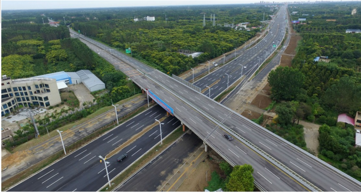
▲ 航拍的京港澳高速公路与永登高速公路交会处互通立交。
