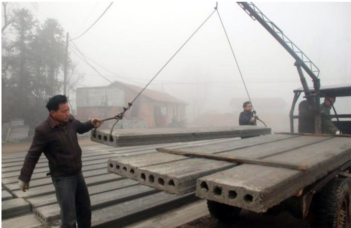
工作人员正在装卸水泥预制板。资料图片
