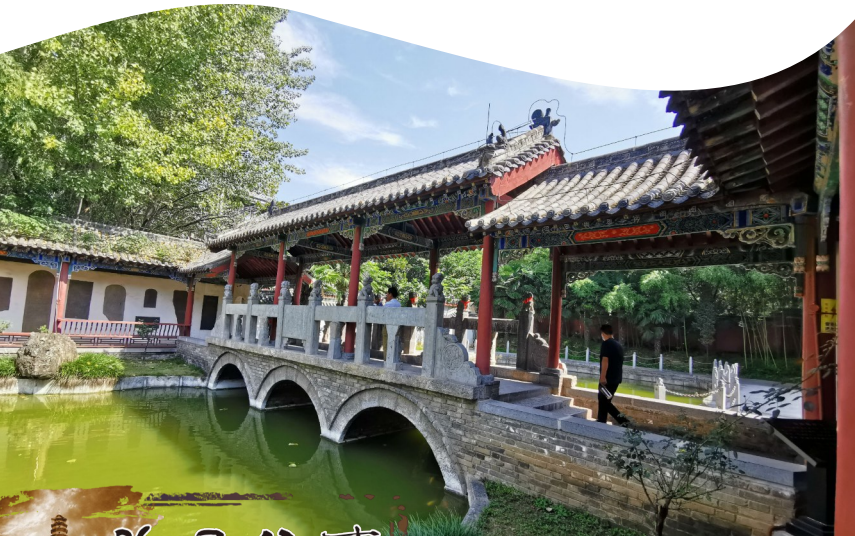
关帝庙内依照古灞陵桥原样修复的桥梁。
