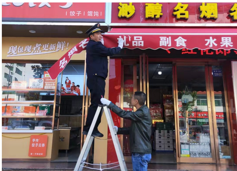
城管队员拆除商户违规设置的伸缩棚。
