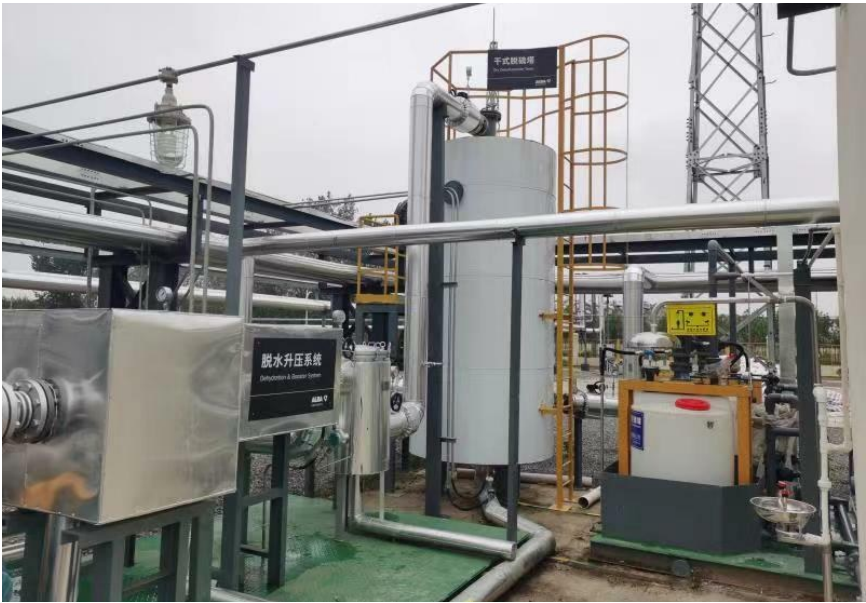
处理车间设备已经安装到位。
