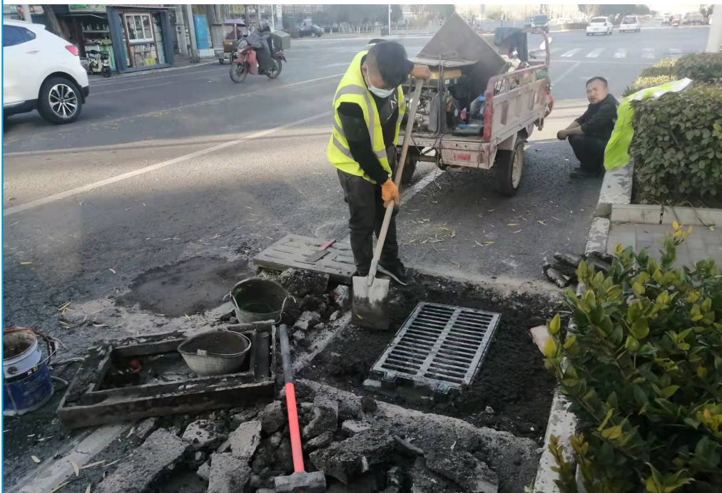
施工人员在更换窰井盖。
