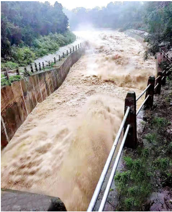
↑ 白沙水库 开工建设现场。 资料图片 ← 白沙水库 开闸泄洪。 记者 吕超峰 摄
