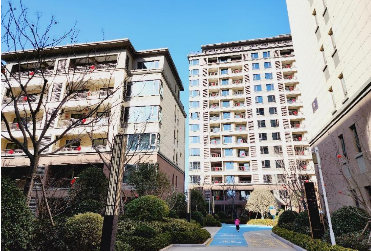
襄城恒达·熙郡实景图 记者 胡永鑫 摄
