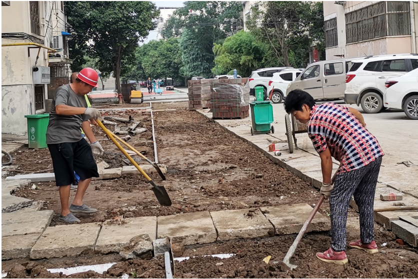
魏都区文峰街道毓秀社区在青竹苑小区进行“四改一增”提升改造
