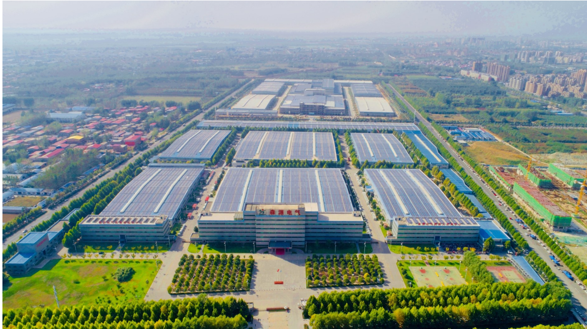
图为森源电气全景
