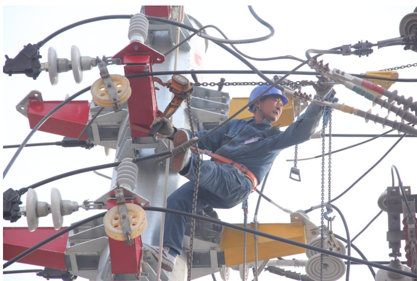
11月29日,在10千伏新区锦华线施工现场,长葛市供电公司的工作人员正在加紧施工,提高长葛市电网冬季供电能力,保障该区域客户温暖过冬。张弓 摄
