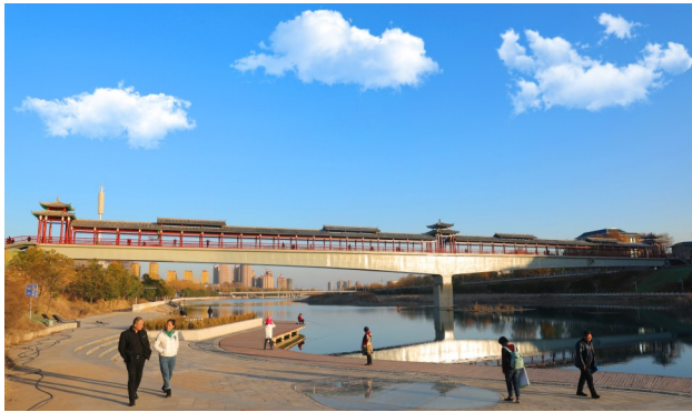
新建成的景观廊桥 孙智高摄
