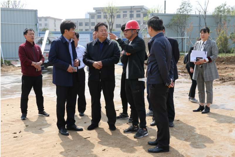
东城区党工委书记朱发业(前排左二)到许昌都路小学项目工地现场办公,确保学校建成精品工程
