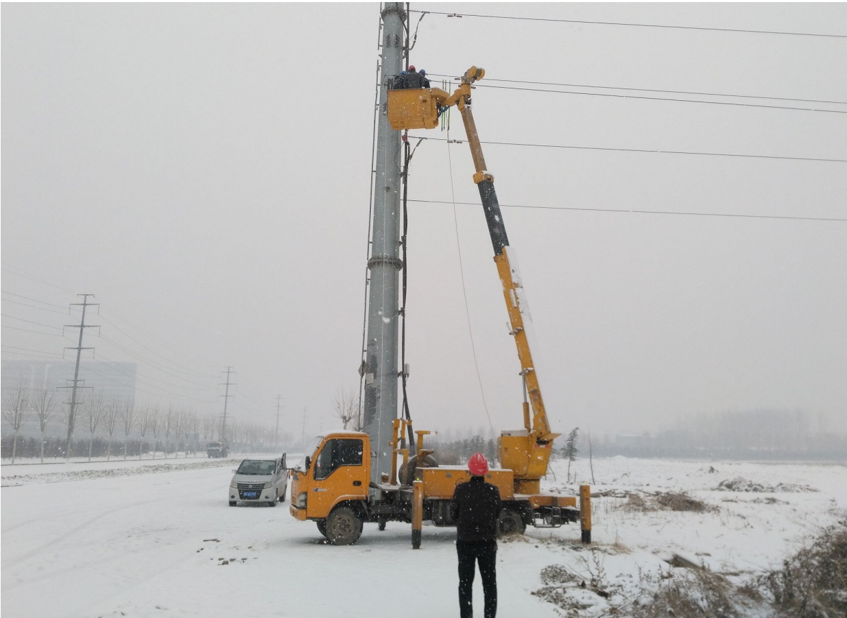
1月9日,长葛市供电公司组织人员对35千伏黄浦线进行抢修。由于天气原因,该条输电线路负荷增高,线路C相避雷器和弓子线烧坏。为尽快恢复线路供电,抢修人员冒着风雪抢修,确保群众温暖过冬。 桂小锋 摄
