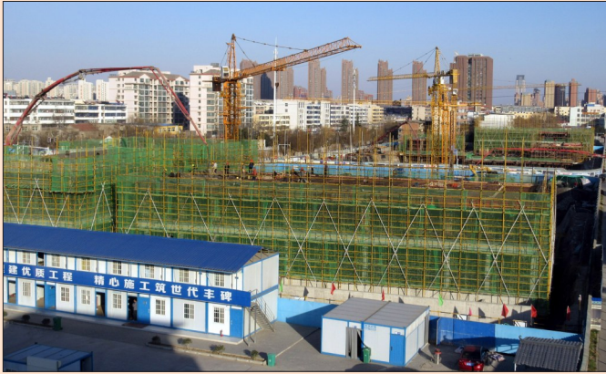
最近,位于魏都区北大街的曹魏古城北城门项目正在加紧施工建设。本报记者 乔利峰 摄
