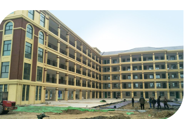
正在施工中的尚东小学
