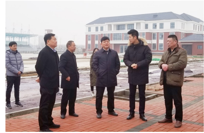
示范区实验学校建设期间,市城乡一体化示范区党工委副书记、管委会副主任杨朝晖(右三)到建设工地查看施工情况
