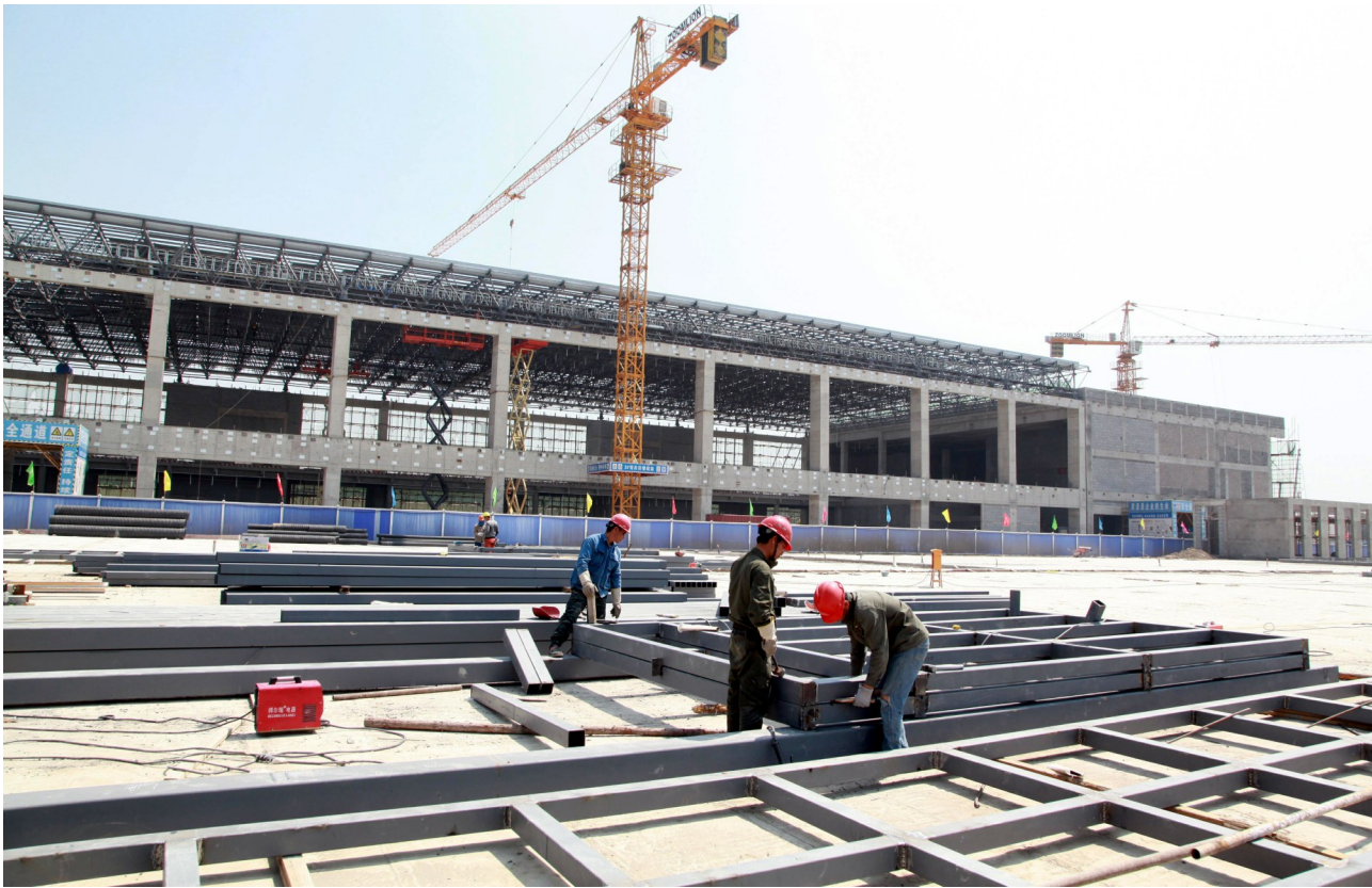
4月20日,郑合高铁许昌北站,工人正加紧站房及站前广场配套设施建设。该站位于建安区东北部,距离许昌主城区10公里,距新郑机场40公里,2019年建成通车后,将成为郑州航空港综合实验区许昌承载区、对外贸易示范区,为许昌拉大城市框架、提高城镇化水平增添新的增长极。
