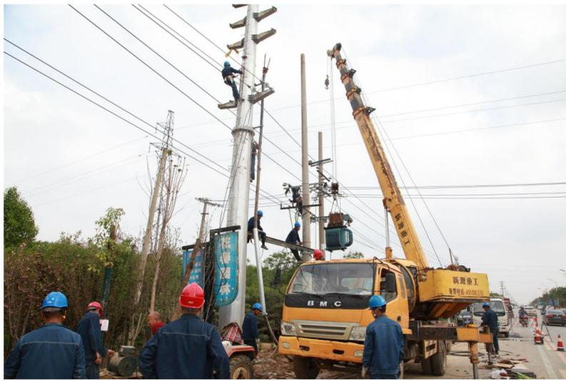
4月24日,在鄢陵县柏梁镇姚家路,电力工人对变压器进行更换。连日来,国网鄢陵县供电公司组织120多名员工对该县10千伏林9永兴线新庄支线进行集中改建施工,改建线路4.6公里,更换水泥电杆89基,为沿线区域经济发展提供可靠电力保障。陈军 寇晓军 摄
