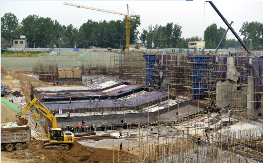
大陈闸除险加固工程施工现场。本报记者 朱宁 摄
