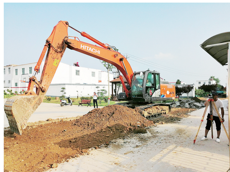
近年来,建安区五女镇大王寨村强化美丽乡村建设,着力改善群众的生产、生活条件,提高群众的幸福指数。图为5月17日,大王寨村正在对该村党群服务中心旁边的一条道路进行提升改造。 秦帅领 靳莹莹 摄
