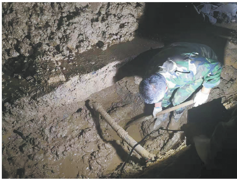
安居物业工作人员正在现场抢修
