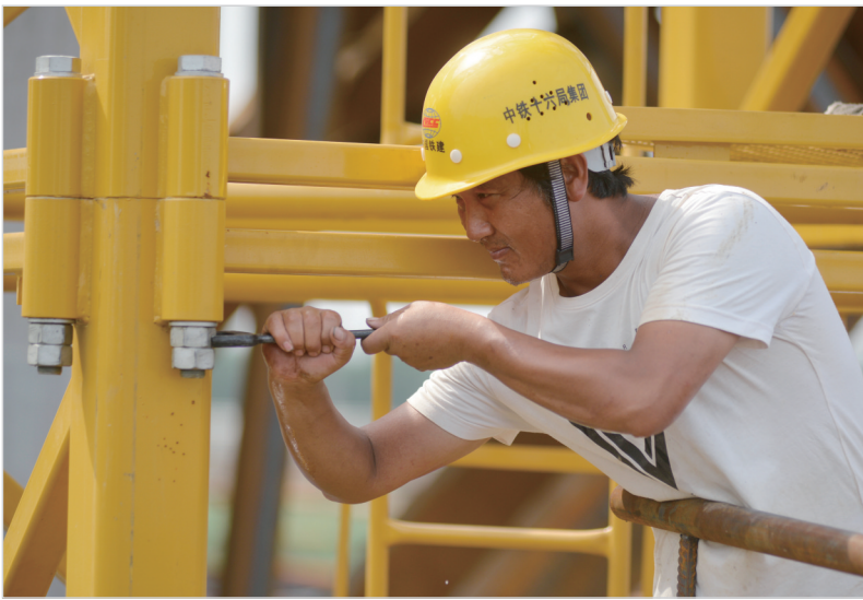
▲中铁十六局的工人在郑许市域铁路长葛市大周镇施工现场忙碌。
