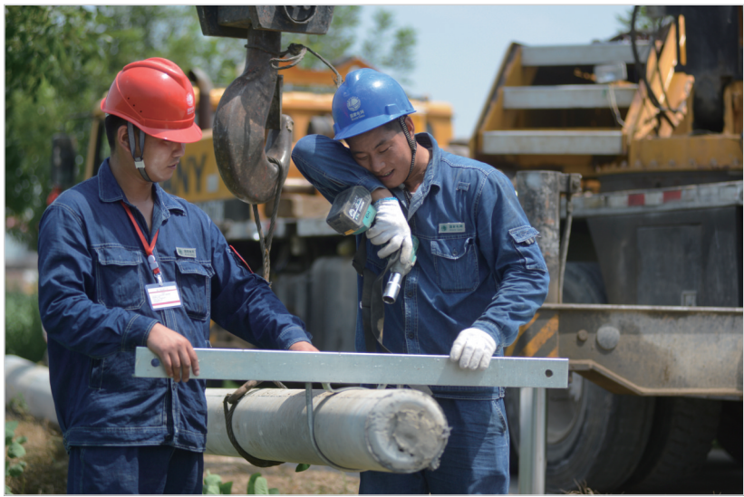
▲国网长葛市供电公司工程人员在大周镇进行新建台区安装施工。
