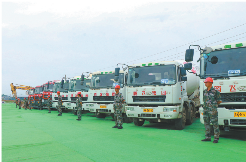
8月1日,北京怀柔科学城许昌中航产业园项目正式开工。何巧学摄
