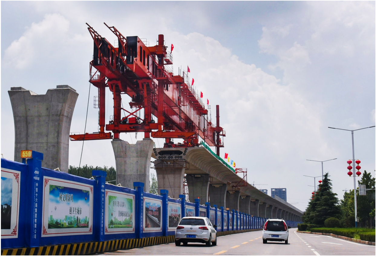
8月6日,郑许市域铁路许昌段永兴东路站,架梁机正在进行下一孔梁的架梁准备。据悉,预计2020年年底前,郑许市域铁路将全线通车。
