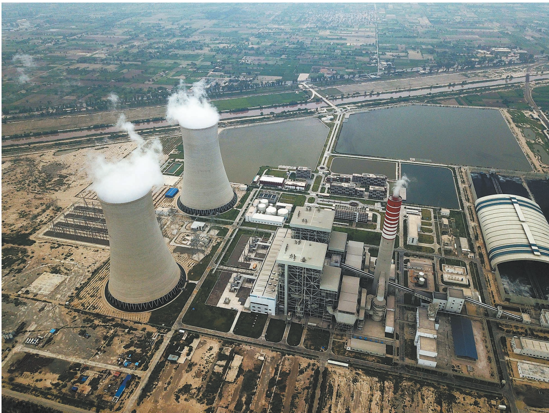
这是8月6日在巴基斯坦东部旁遮普省萨希瓦尔航拍的萨希瓦尔燃煤电站。
