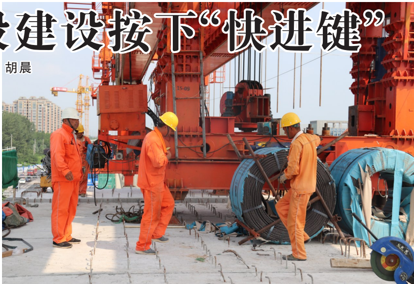
在郑许市域铁路许昌段工程第二项目部,工人们正在架设箱梁。 胡晨 摄
