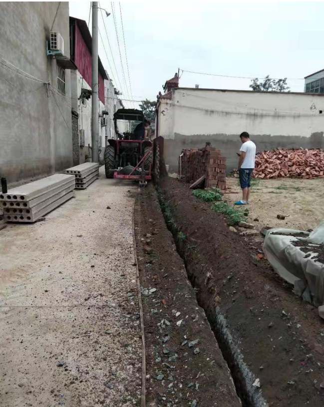
工人们正在加紧铺设自来水管道(市水利局提供)
