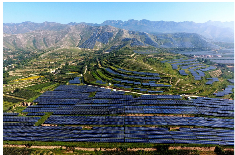
这是8月29日无人机拍摄的芮城光伏基地一角。近年来,山西省芮城县积极探索利用荒山荒坡发展光伏发电,目前已建成装机容量50万千瓦的光伏电站,2018年发电量达7.32亿千瓦时。新华社发
