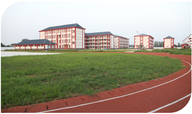
建安区三年攻坚中新建的张浦镇一中小学部
